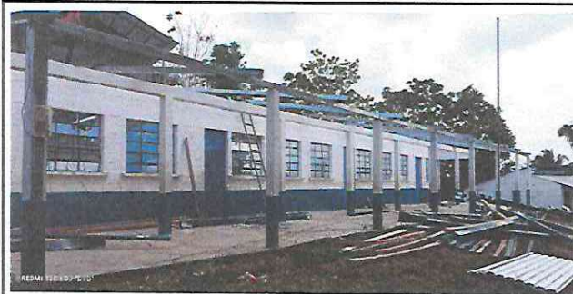
Foto 5: Instalación de costaneras y tijeras.
