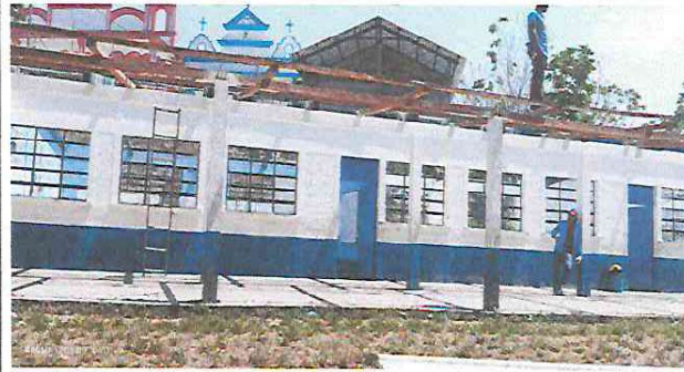
Foto 2: En este foto es cuando se empezó a quitar las carga láminas, costaneras y tijeras.
