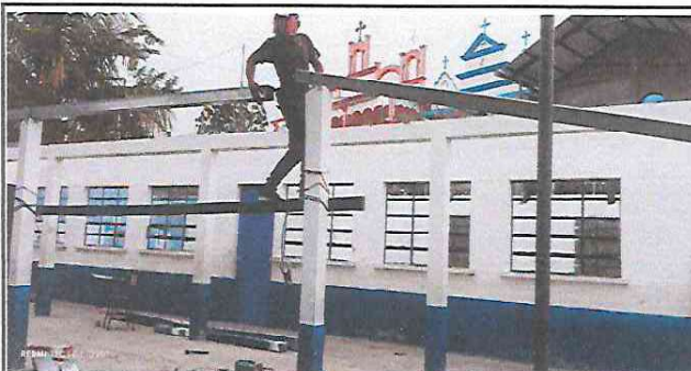
Foto 3: Aquí en este foto, cuando se empezó a instalar las costaneras metálicas.
