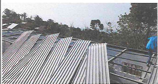
Foto 1: En esta imagen, es cuando se empezó quitar las láminas de la Escuela del Módulo 1
