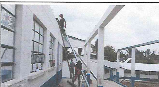
Foto 4: Seguimiento de instalación de costaneras.
